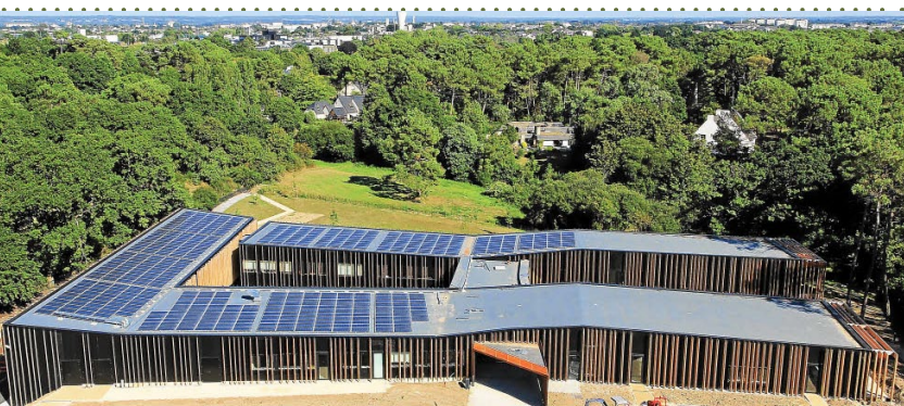
Le bâtiment à énergie positive de Morbihan Energies à Vannes © P. Labbé / Balloïde-Photo
